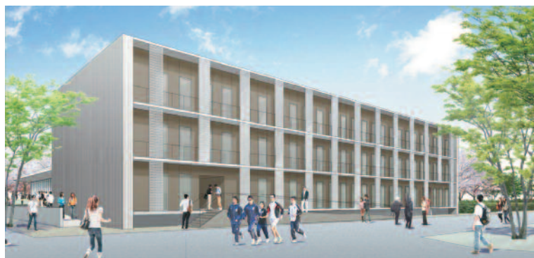
クラブ棟外観
